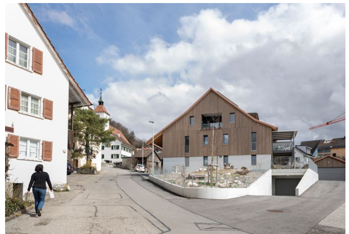
Das neue Genossenschaftshaus mit Dorftreff und Garten schafft zusammen mit dem Froh Inn und dem Bierhüsli (beide unterhalb des Bildausschnitts) einen neuen Dorfplatz in Himmelried.
